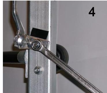
Montare il piede d'appoggio, avvitarlo completamente verso il basso e farlo scorrere lungo la piastra incollata. Montare il controdado D (vedere foto 3+4 e fig. 1).
