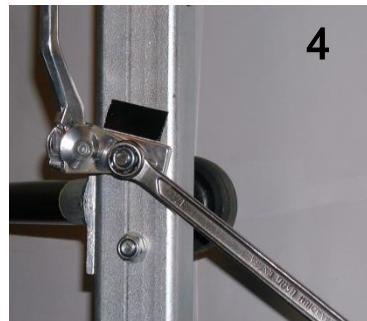
Установите опору, затяните ее и расположите параллельно наклеенной пластине. Завинтите контргайку D (см. илл. 3+4 и рис. 1).
