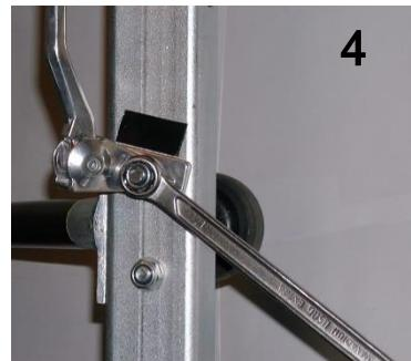
Montera stödmutter I. Skruva ner den helt i botten och placera den längs den pålimmades plattan. Montera låsmutter D (se bild 3+4 och fig. 1).
